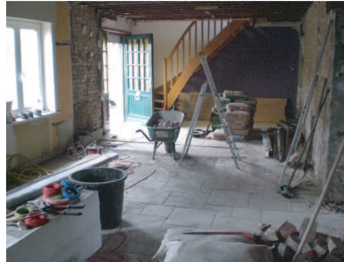
VUE DU SALON PENDANT TRAVAUX
