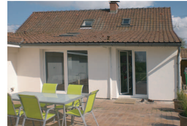
FAÇADE ARRIÈRE APRÈS TRAVAUX
