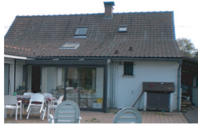
FAÇADE ARRIÈRE AVANT TRAVAUX
