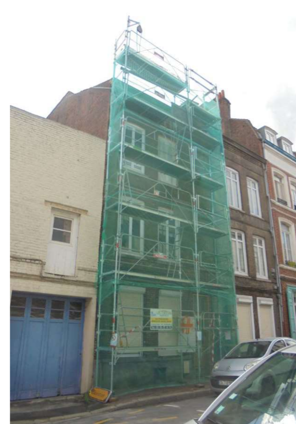
ETAT PROJETE - Photo de chantier travaux en cours (ravalement de façade)
