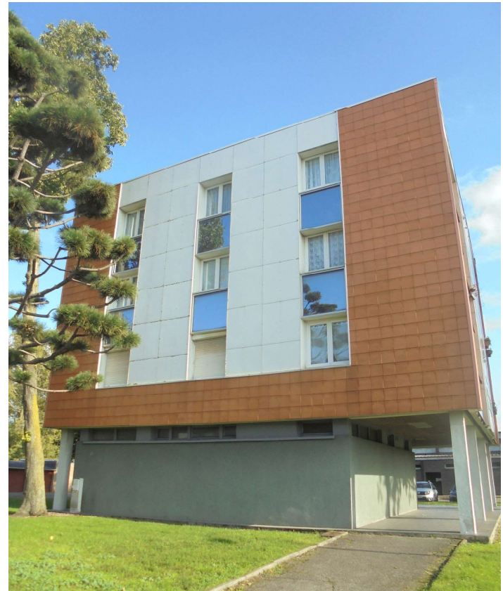
ETAT EXISTANT - Facade Ouest
