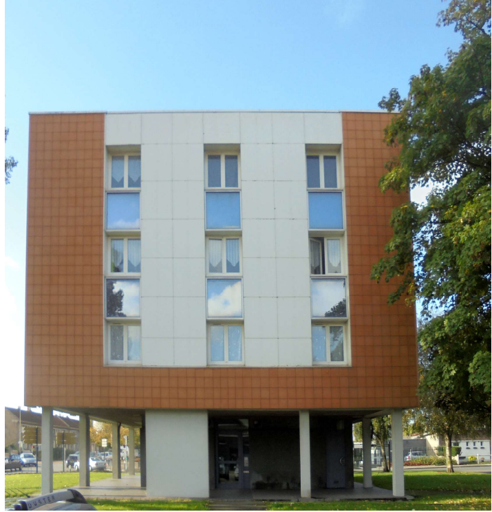
ETAT EXISTANT - Facade Est
