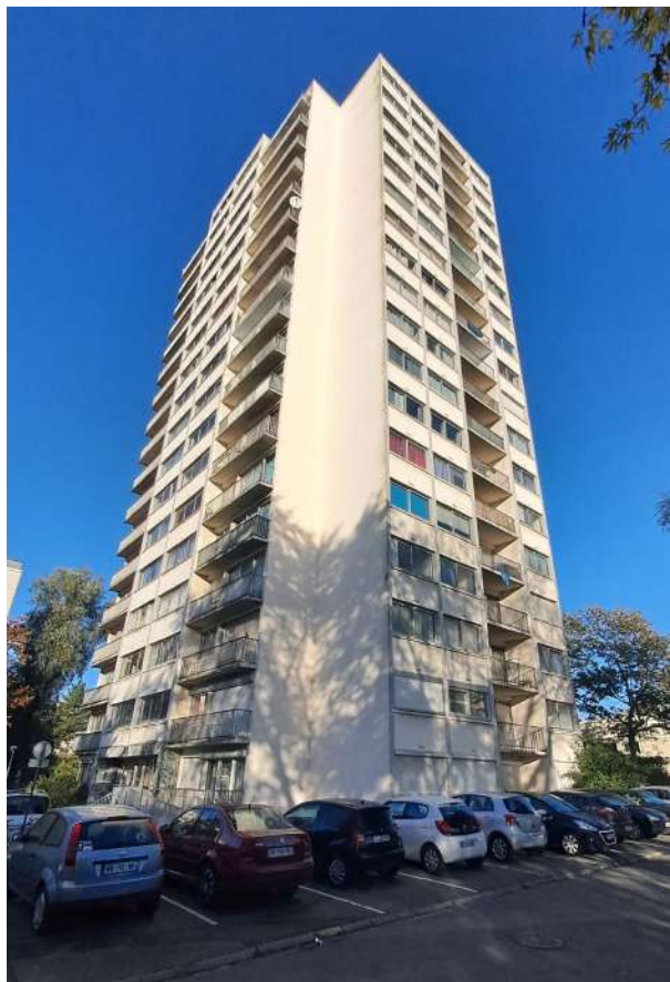
ETAT EXISTANT - VUE AVANT TRAVAUX
