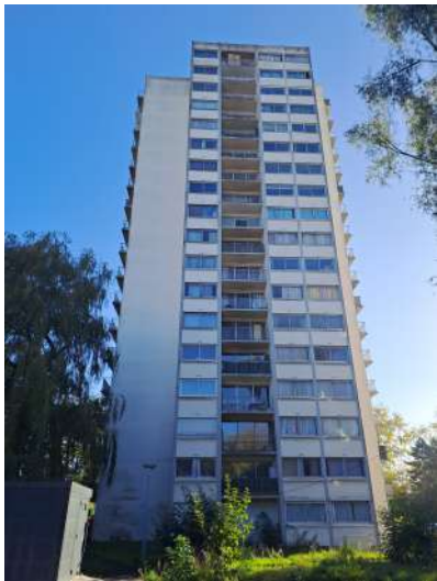
ETAT EXISTANT - VUE AVANT TRAVAUX
