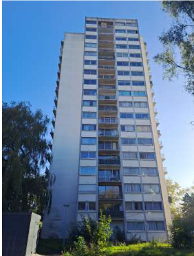
ETAT EXISTANT - VUE AVANT TRAVAUX
