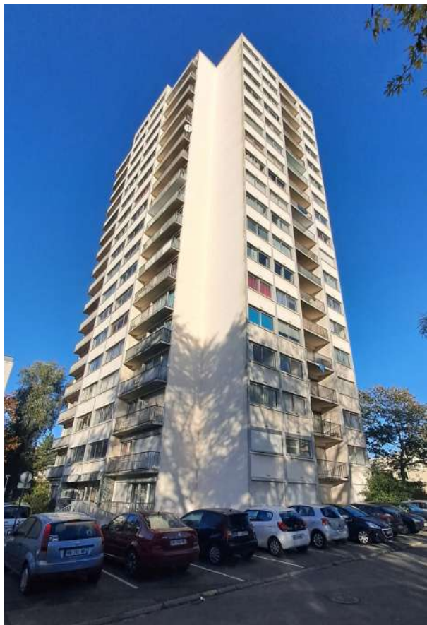
ETAT EXISTANT - VUE AVANT TRAVAUX
