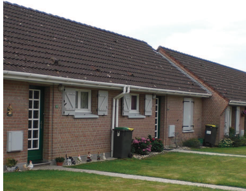
FACADE AVANT TRAVAUX: - isolation thermique interieure.
