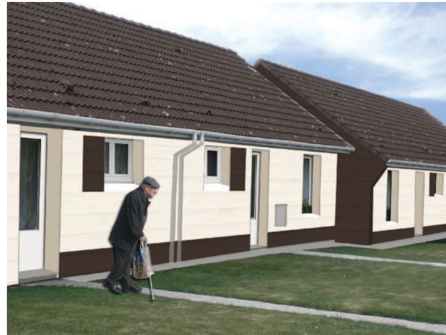
FACADE APRES TRAVAUX: - isolation thermique extérieure
