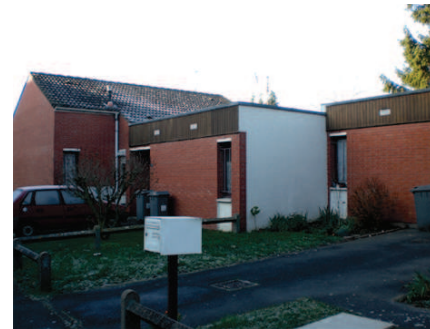
FAÇADE COTE RUE AVANT TRAVAUX
