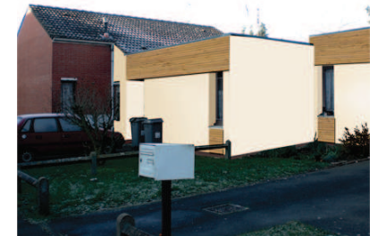
FAÇADE COTE RUE APRES TRAVAUX
