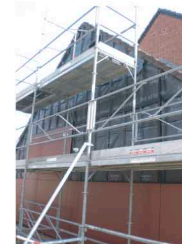
ISOLATION DES PIGNONS PAR BARDAGE
