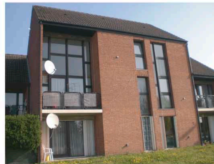
FACADE AVANT TRAVAUX
