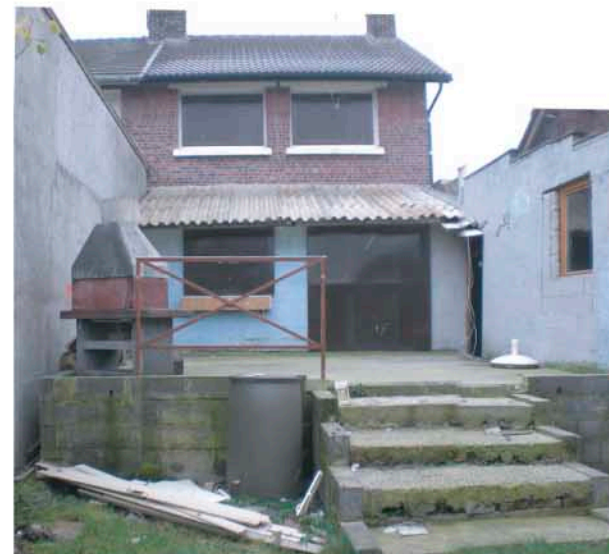
FACADE ARRIERE AVANT TRAVAUX
