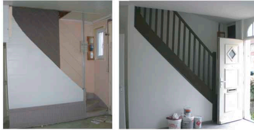
VUE DE L'ESCALIER AVANT ET APRES TRAVAUX
