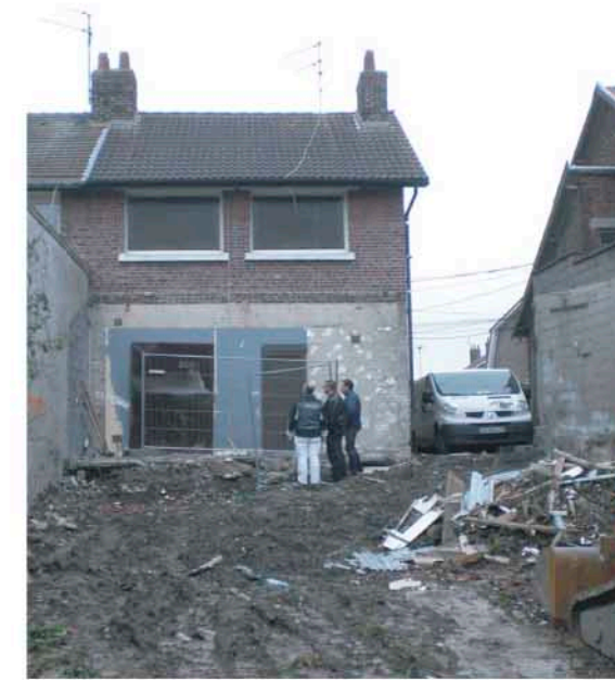
FACADE ARRIERE PENDANT TRAVAUX
