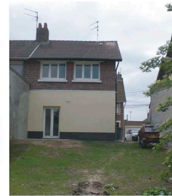
FACADE ARRIERE APRES TRAVAUX
